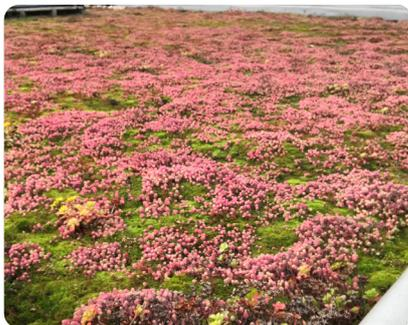
*Bei der extensiven Dachbegrünung können die Pflanzen das angesammelte Regenwasser filtern, sodass es beispielsweise zur Toilettenspülung genutzt werden kann*
